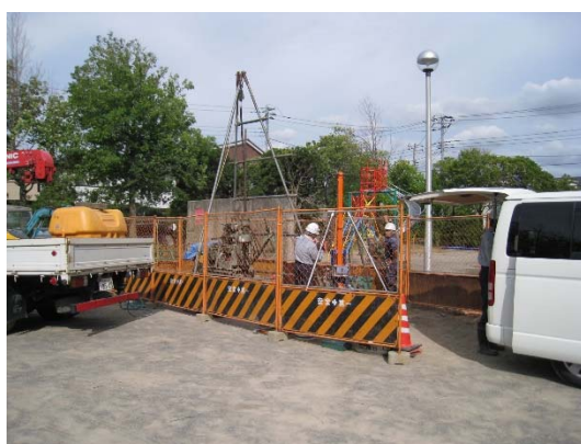
写真 1-1 ボーリング調査 (標準貫入試験・PDC 試験)
