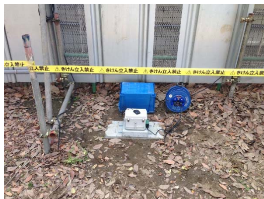
写真 1-6 地震計（矢板外）
