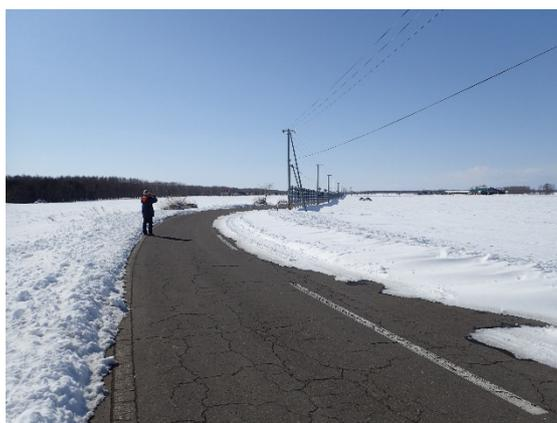
図16 中標津町西竹の町道付近における吹きだまり状況。2016年2月27日。道路風上側の車線が吹きだまりで覆われており、普通車の走行は困難な状態である。
