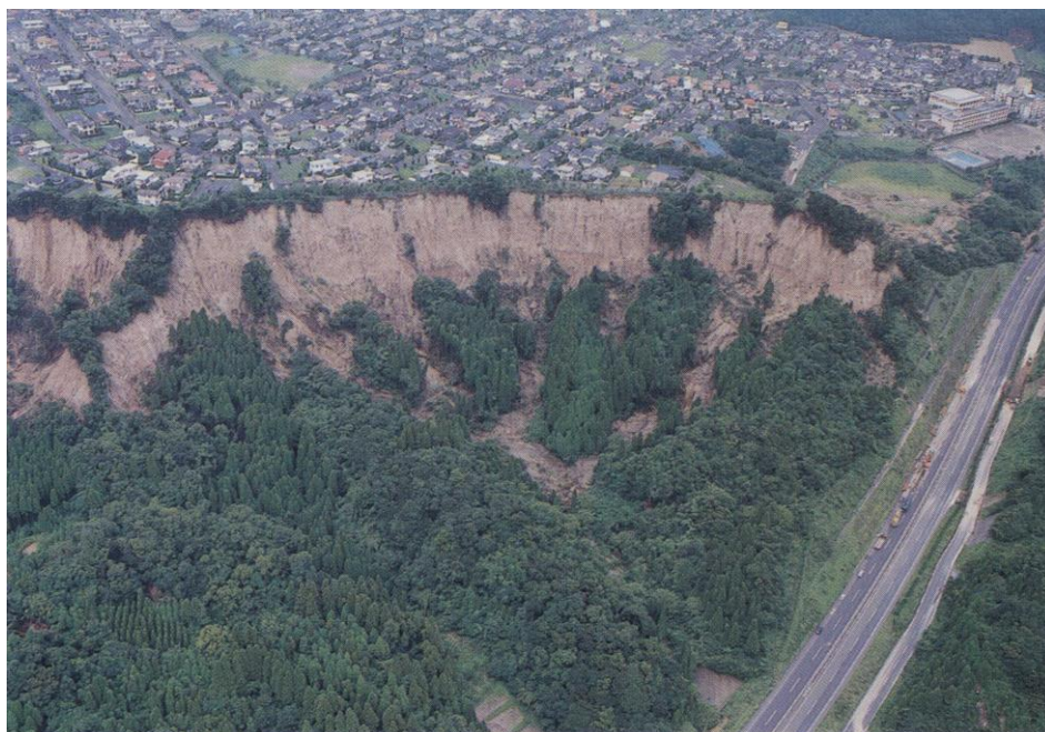
図2-4 始良町平松始良ニュータウン周辺のシラス台地の崩壊（国際航空写真株式会社撮影）。
