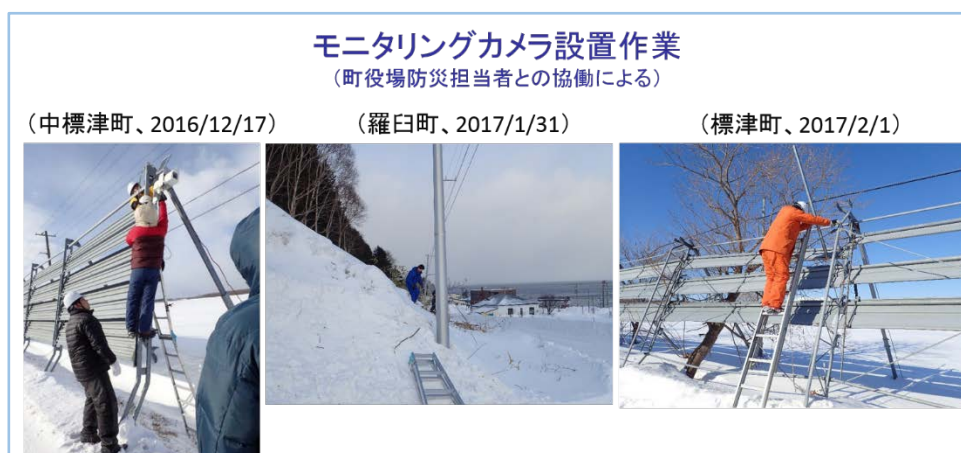
図 21 現地におけるライブカメラ設置作業。町役場の防災担当者（運営委員）と共に実施した。
