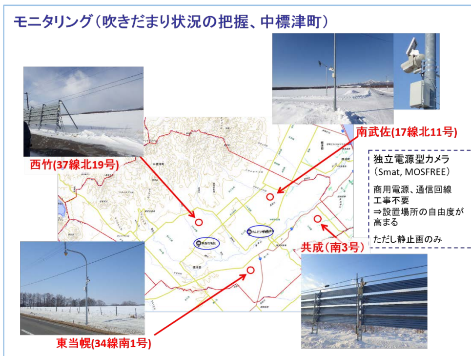
図 11 独立電源型カメラを用いた吹雪、吹きだまりモニタリングシステム（中標津町）。
