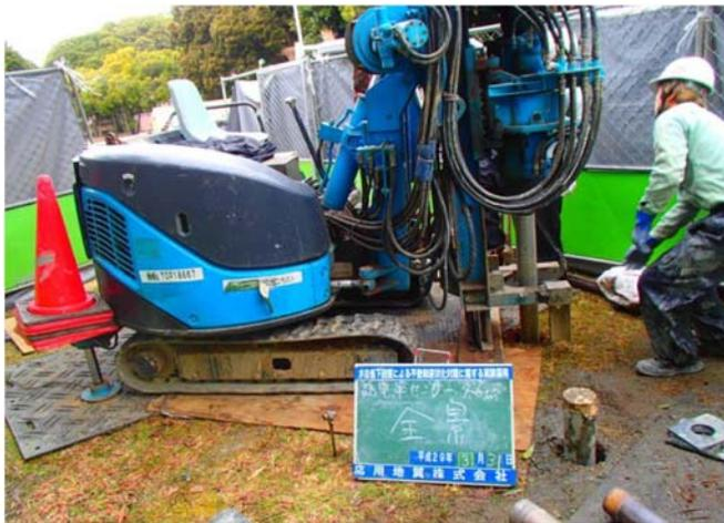
写真 2-1 観測井掘削状況
